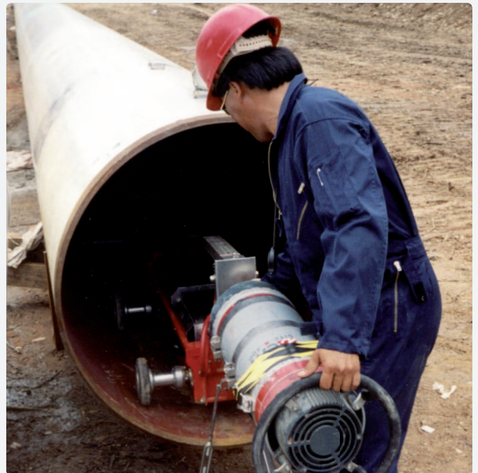
1.2 Crawler im Einsatz
